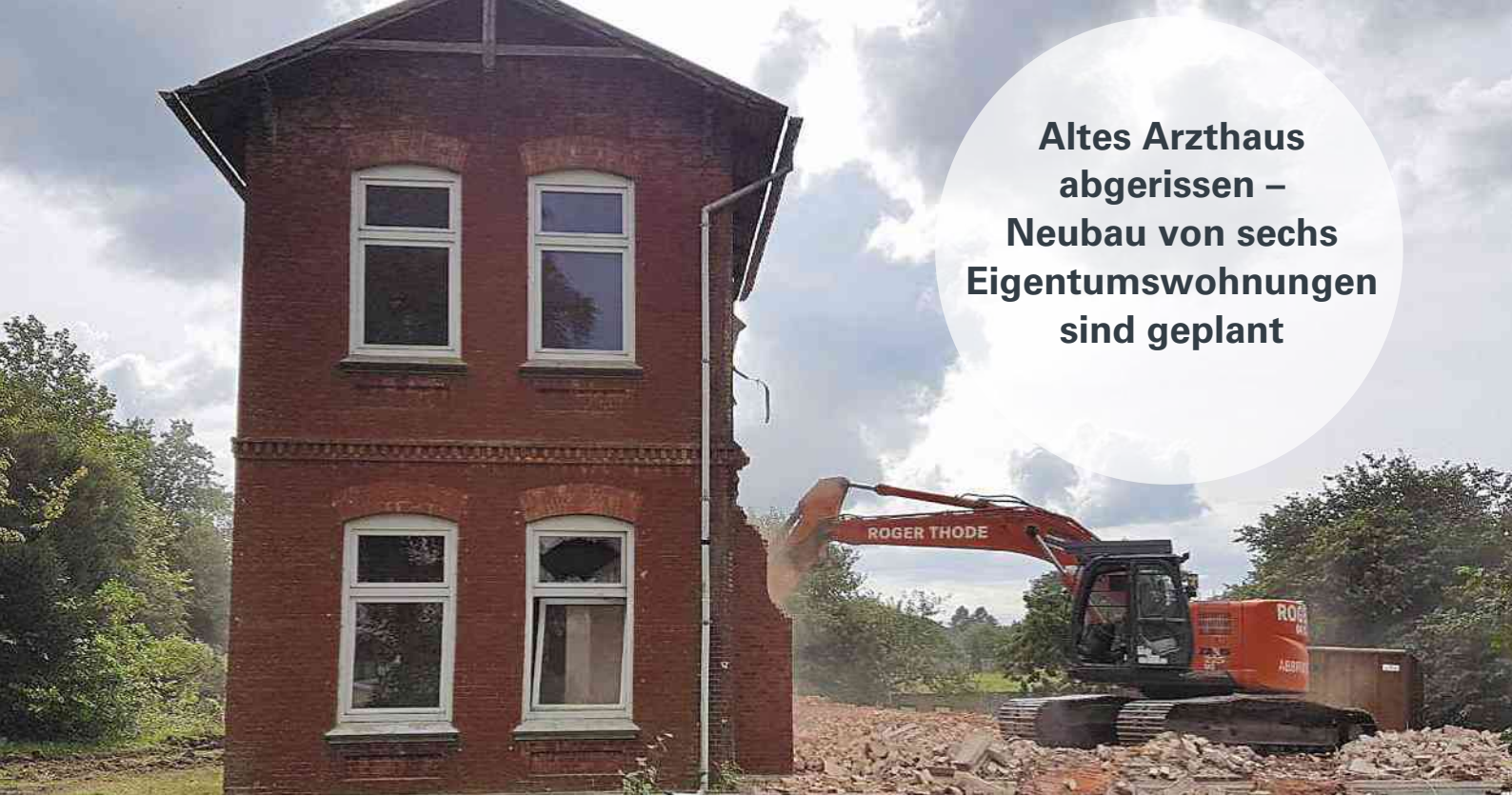
Der Abriss des alten Arzthauses schafft Platz für den Bau eines neuen Wohnhauses. Foto: Günther
