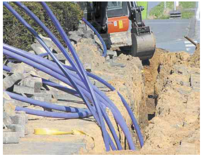
Verlegen von Leerrohren für Glasfaserleitungen
