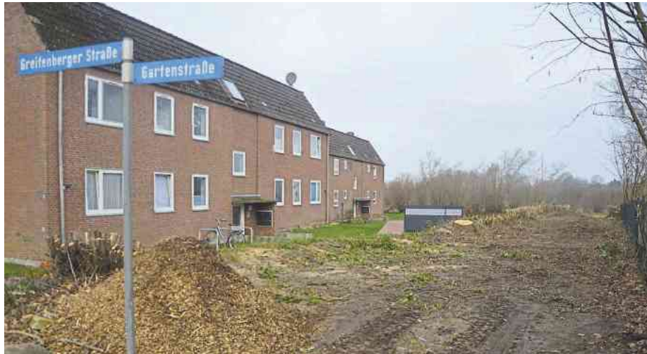
Hinter der Bebauung an der Greifenberger und der Gartenstraße soll das Neubaugebiet entstehen. Foto: Müller
