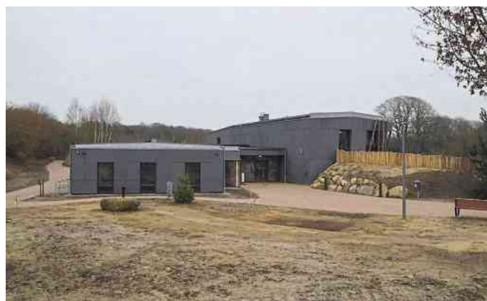
Hier geht's in die Steinzeit: Der neue Eingang befindet sich zwischen dem Bestandsgebäude (links) und dem neuen Ausstellungsgebäude.
