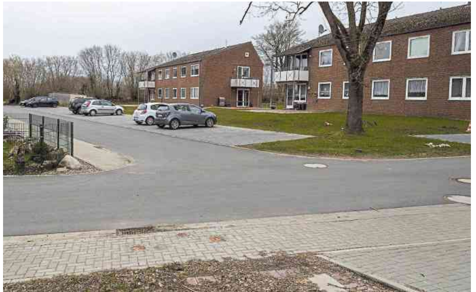
Die Straßen, Gehwege und Parkflächen rund um das Quartier um die Greifenberger Straße wurden umfassend saniert.
